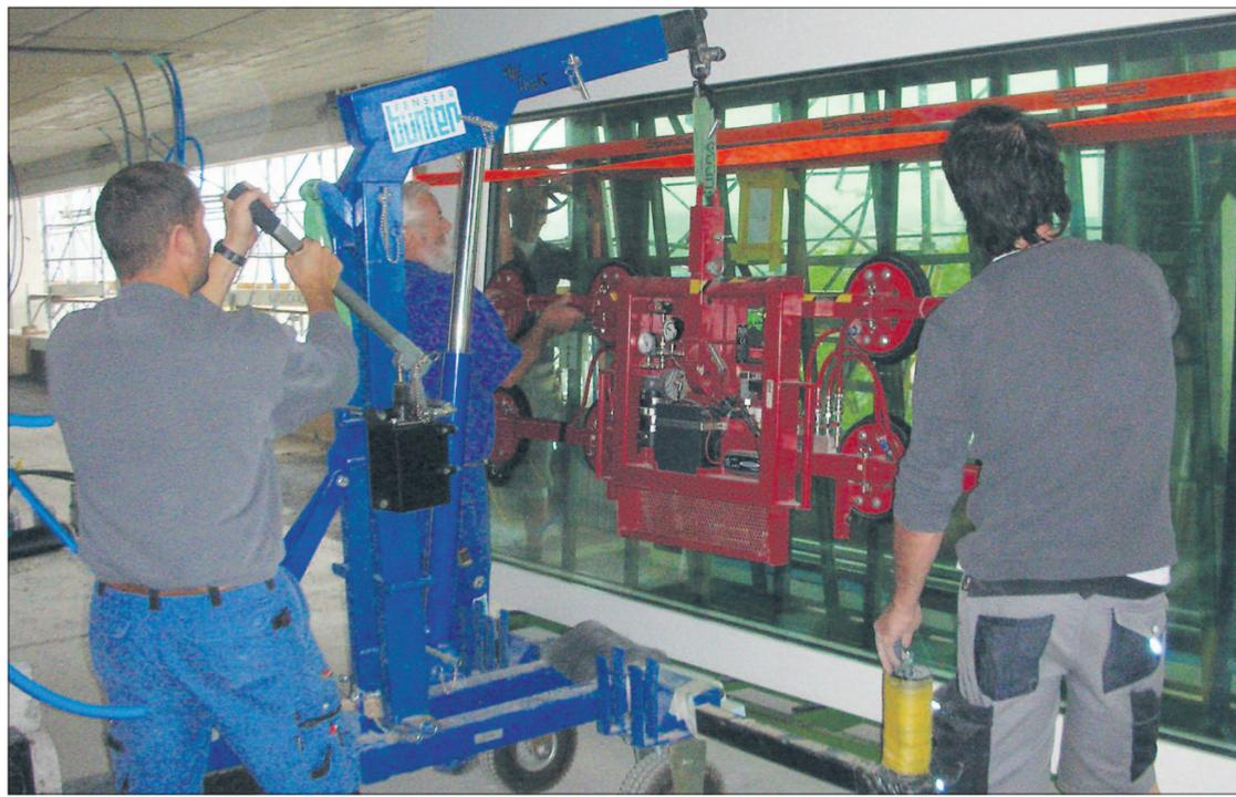
Mit einem selbst erfundenen und zum Patent angemeldeten Hebegerät montieren Mitarbeiter der Firma Fenster Bünter AG die schweren Glasfronten.
